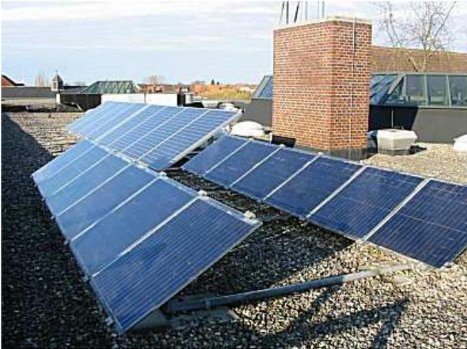
Um das zu zeigen, hat der Klimaschutzfonds Wedel e.V. schon 1998 eine Demonstrationsanlage auf dem Dach des Rathauses mit einer maximalen Kapazität von rund 1,2 kW errichtet. Im Jahr 2001 wurde die Anlage in der zweiten Ausbaustufe auf eine maximale Kapazität von 3,4 kW erweitert. Die Solarpaneele sind auf eine Metallrahmenkonstruktion montiert, die für eine gute Kühlung der Paneele und damit einen recht hohen Jahresertrag von an die 3.000kWh sorgt.
