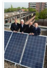
Über den Dächern von Wedel: die vom Klimaschutzfonds initiierte PV-Anlage auf dem Rathausdach.
